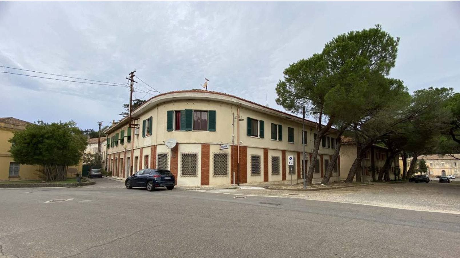
Veduta d'insieme da Sud-Est
