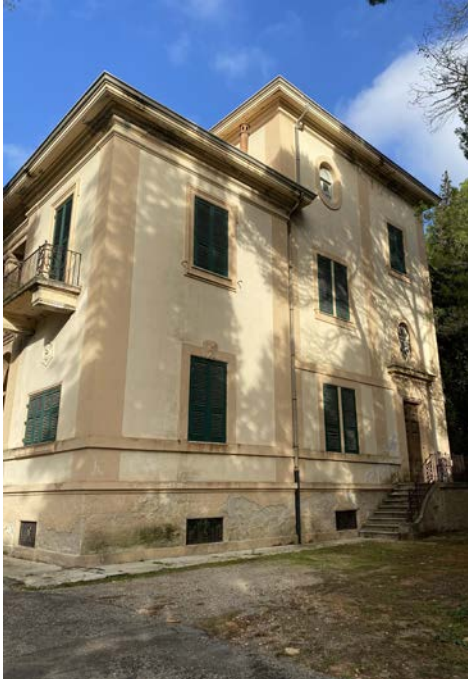
Veduta del prospetto Est
