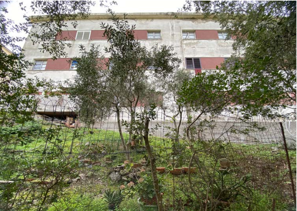
Veduta del prospetto posteriore a Nord
