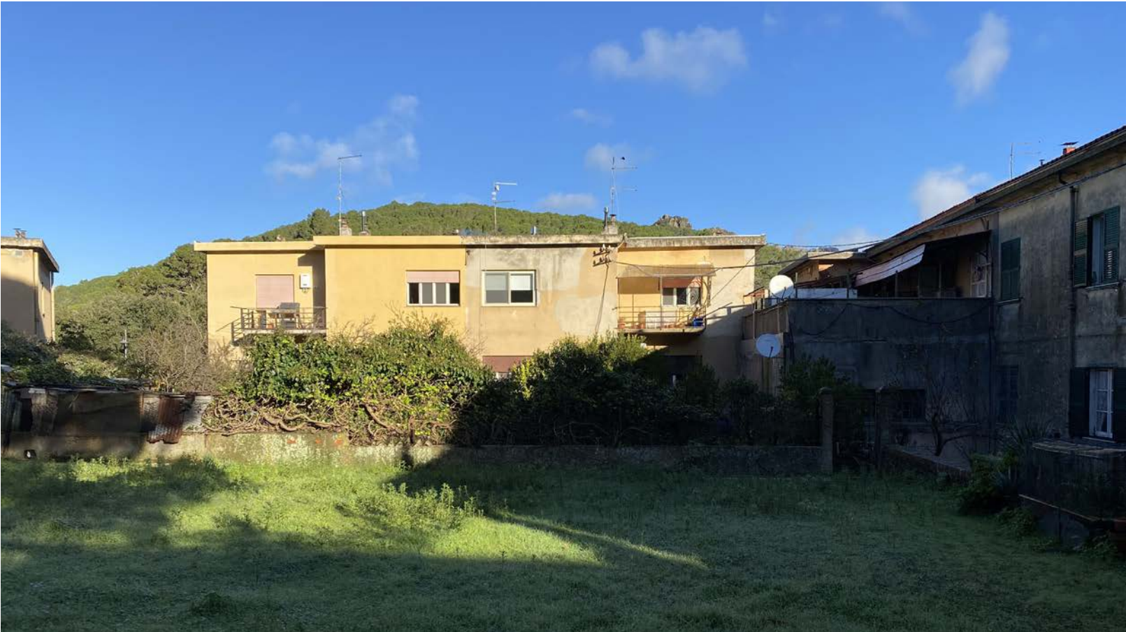
Veduta del prospetto posteriore a Sud con copertura del balcone incongrua
