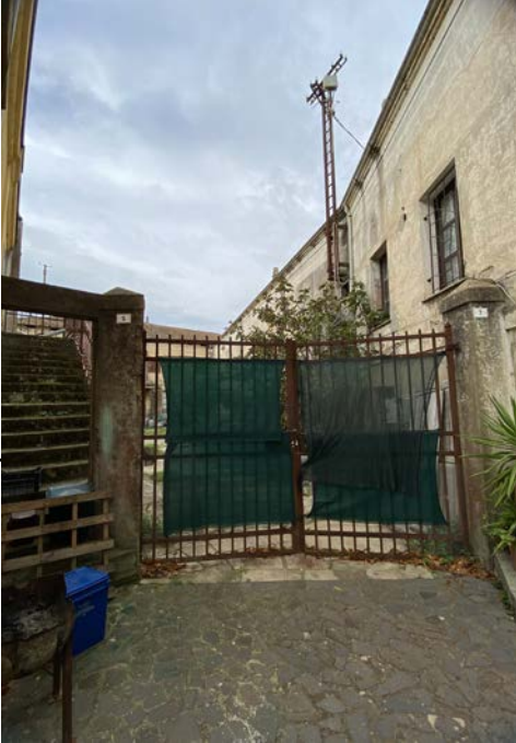
Accesso carrabile su prospetto posteriore
