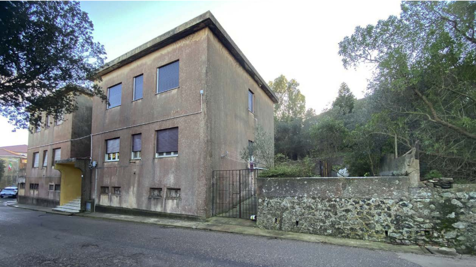
Veduta del prospetto Nord su viale Vittorio Veneto
