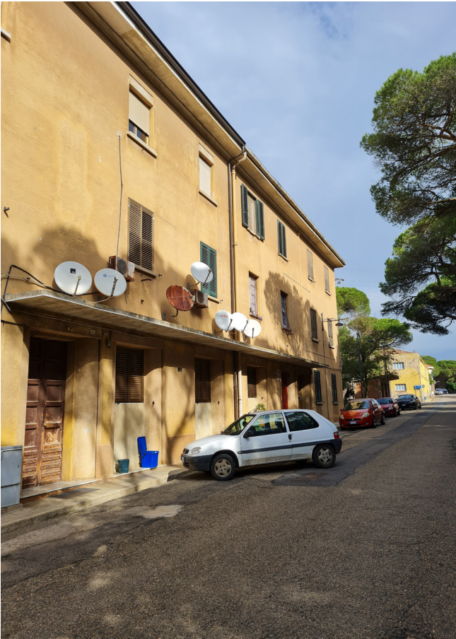
Scorcio del prospetto su via Amendola
