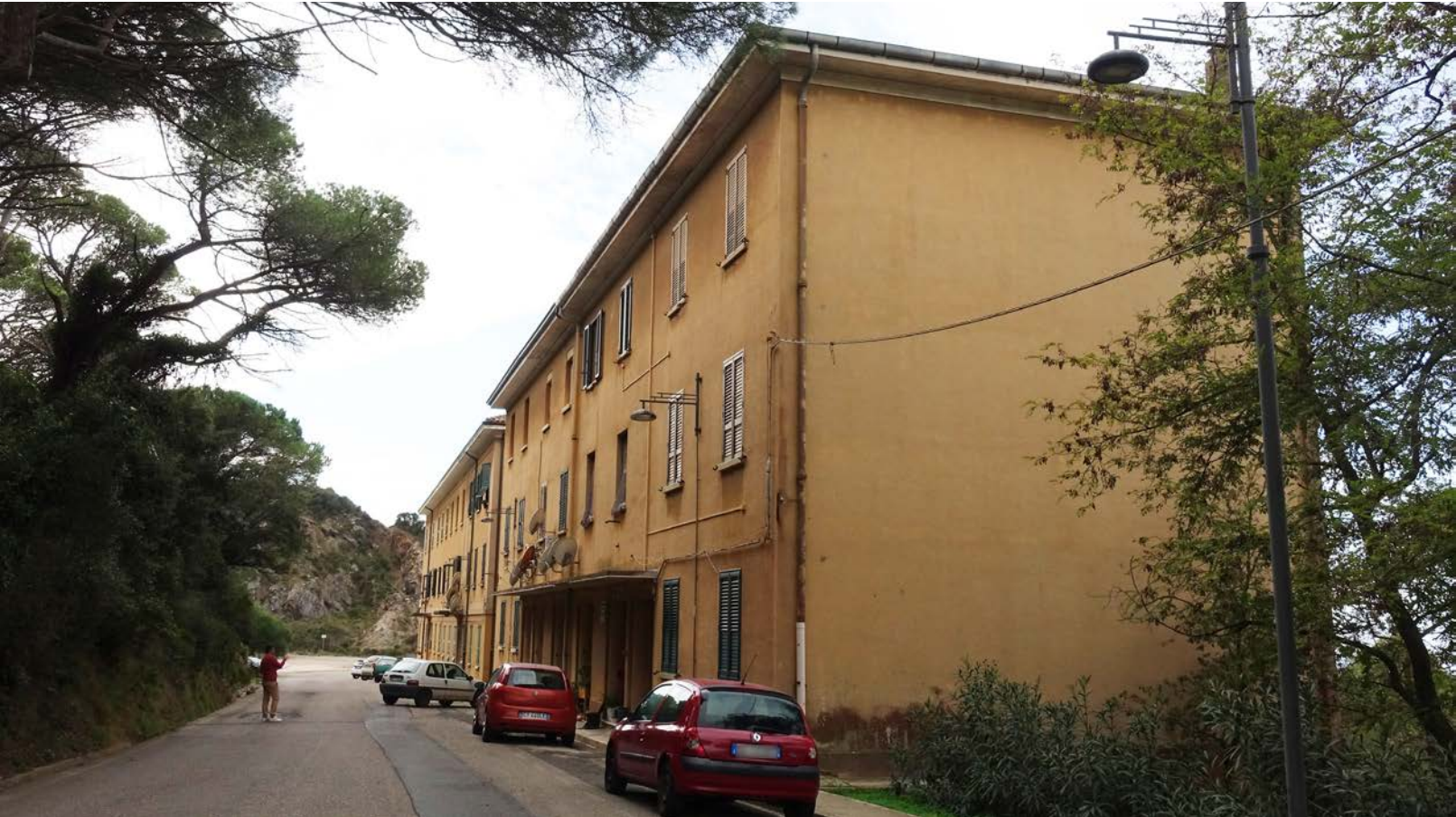
Veduta dei fabbricati su via Amendola
