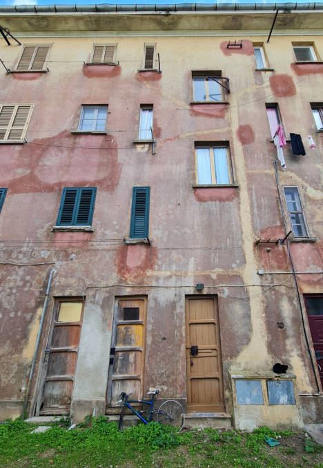
Dettaglio del prospetto posteriore
