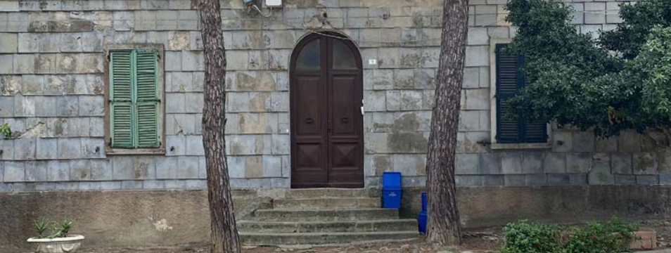
Rivestimento in ardesia, scale e serramenti da preservare
