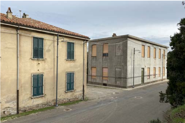
Veduta d'insieme da Sud-Ovest
