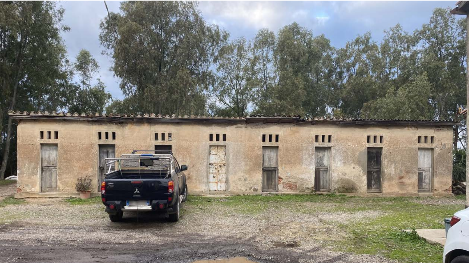
Veduta del prospetto Est
