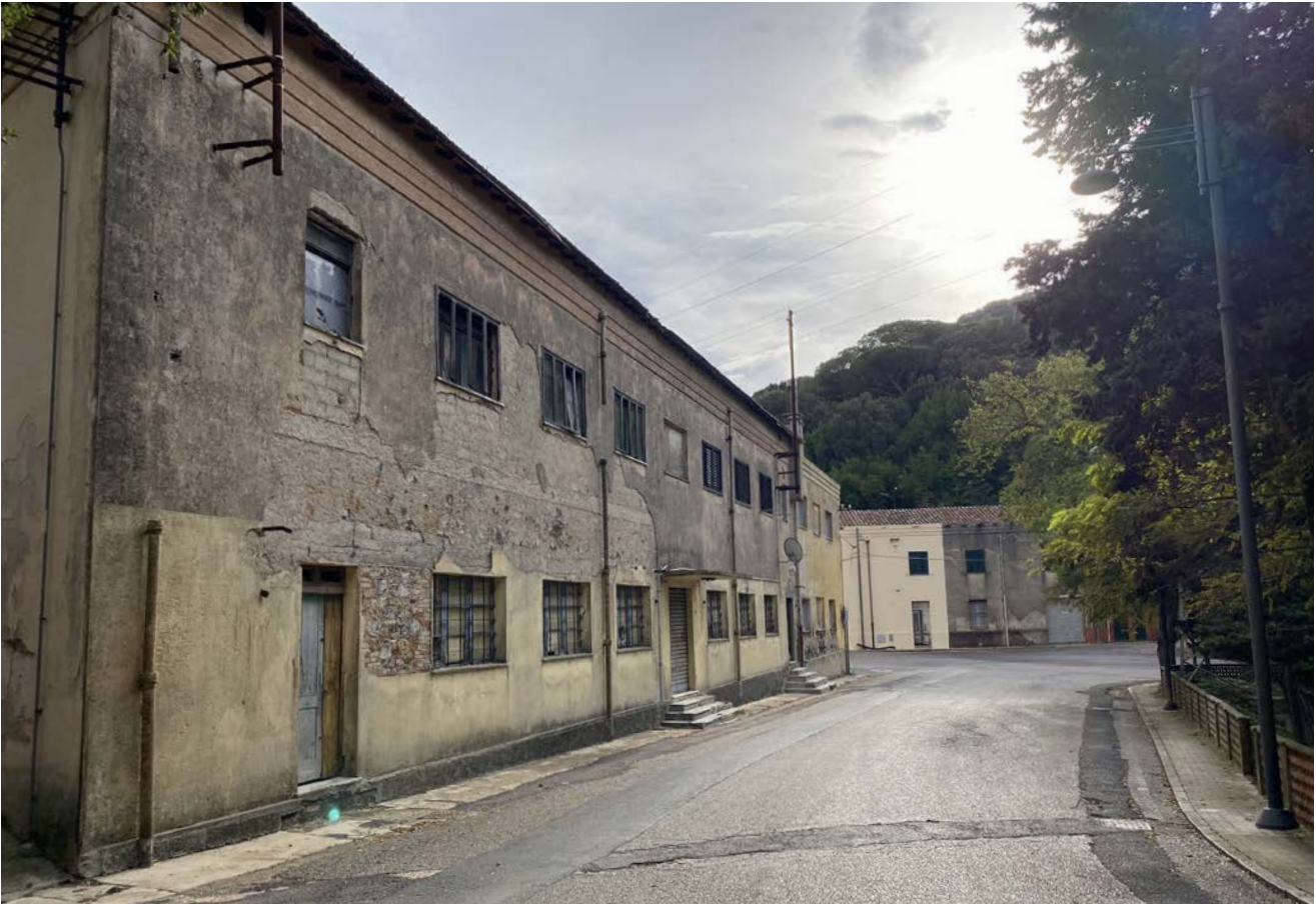
Veduta del prospetto Sud-Ovest su viale Vittorio Veneto
