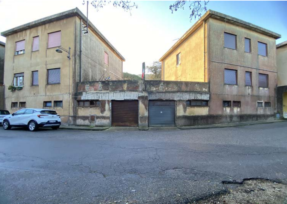
Veduta d'insieme di parte degli edifici 9 e 10
