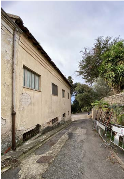
Scorcio del prospetto Nord
