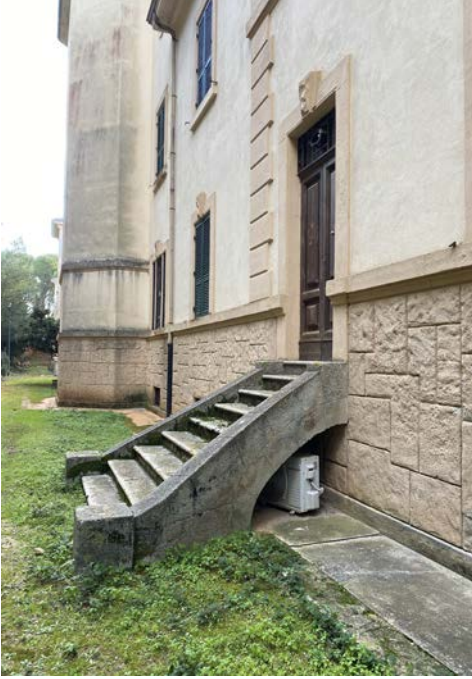
Accesso sul retro (installazione macchina climatizzazione incongrua)
