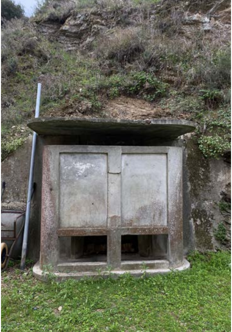
Elemento in C.A. negli spazi posteriori
