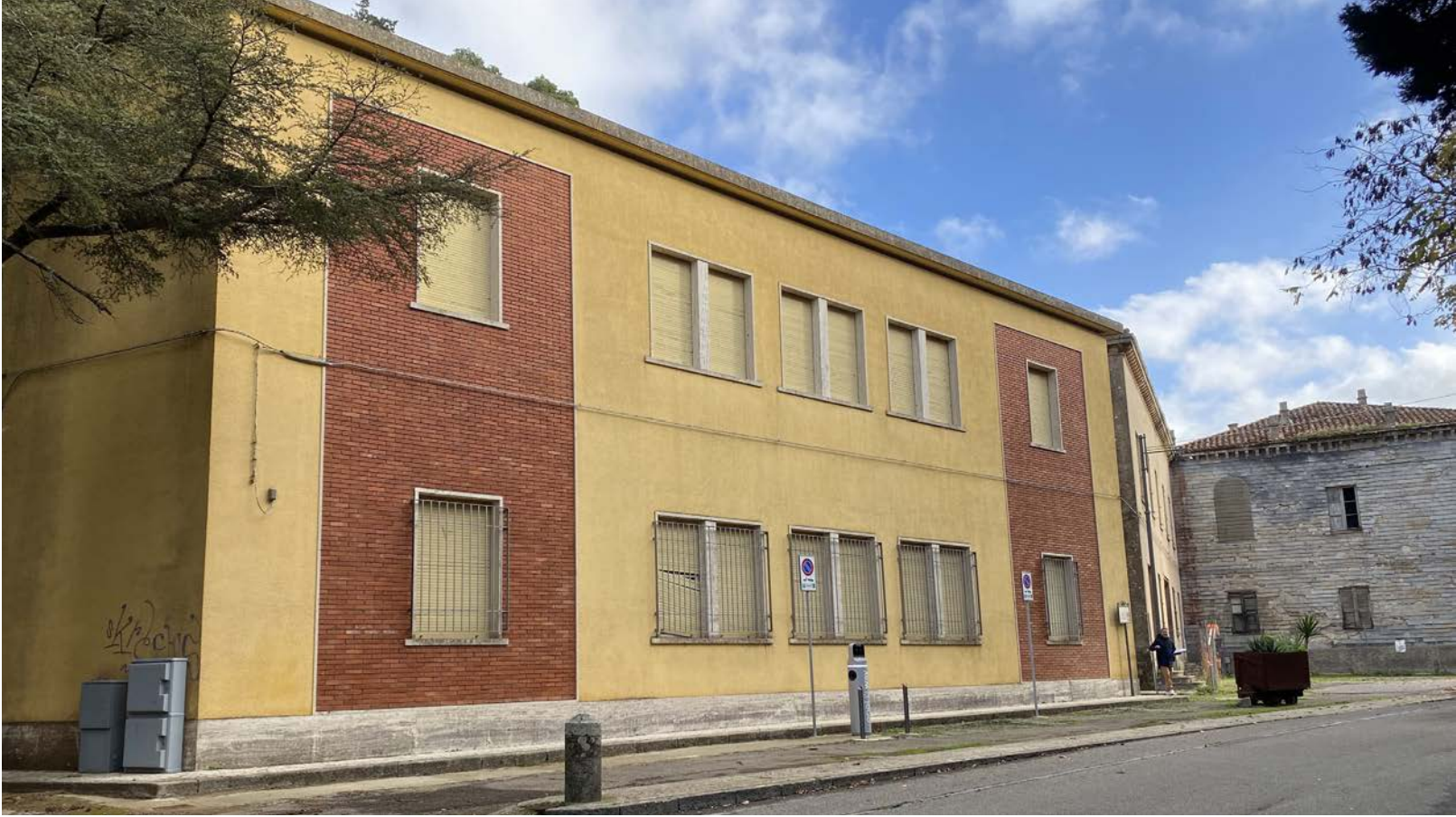
Prospetto principale sulla strada provinciale n. 65
