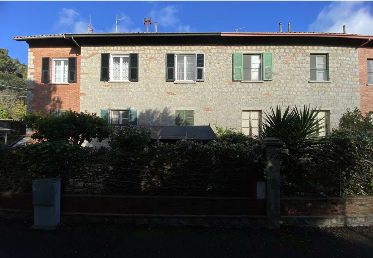
Veduta del prospetto principale Sud
