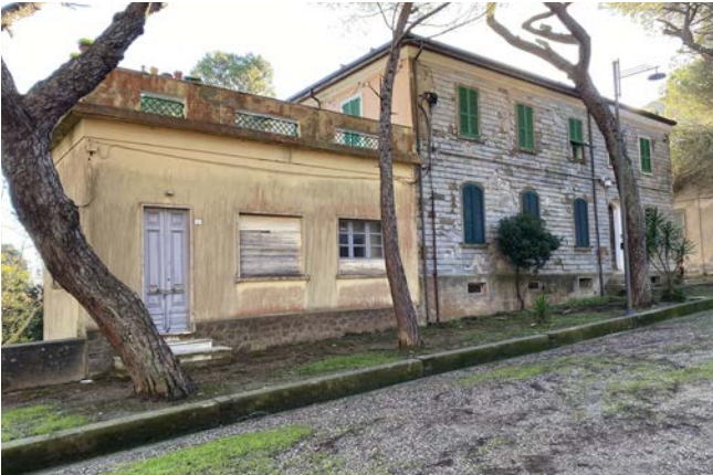
Facciata principale su viale Gramsci
