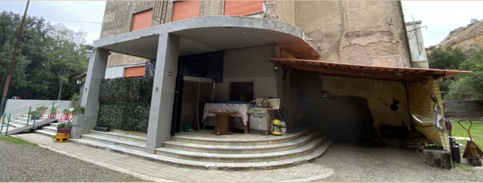
Esempio di gesto modernista: pensilina di accesso
