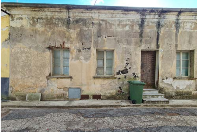
Dettaglio di facciata, porzione Est
