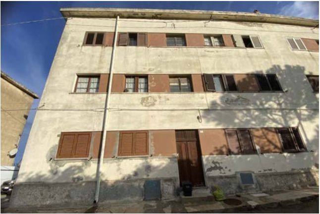
Lato Ovest del prospetto principale a Sud
