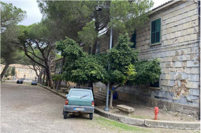
Scorcio della facciata su viale Gramsci
