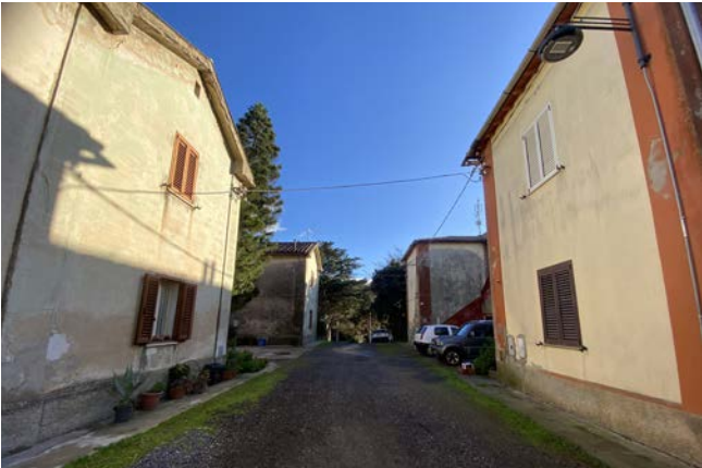
Vista della corte aperta tra edificio 11 e 13
