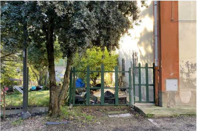
Scorcio sul prospetto Est con accesso incongruo
