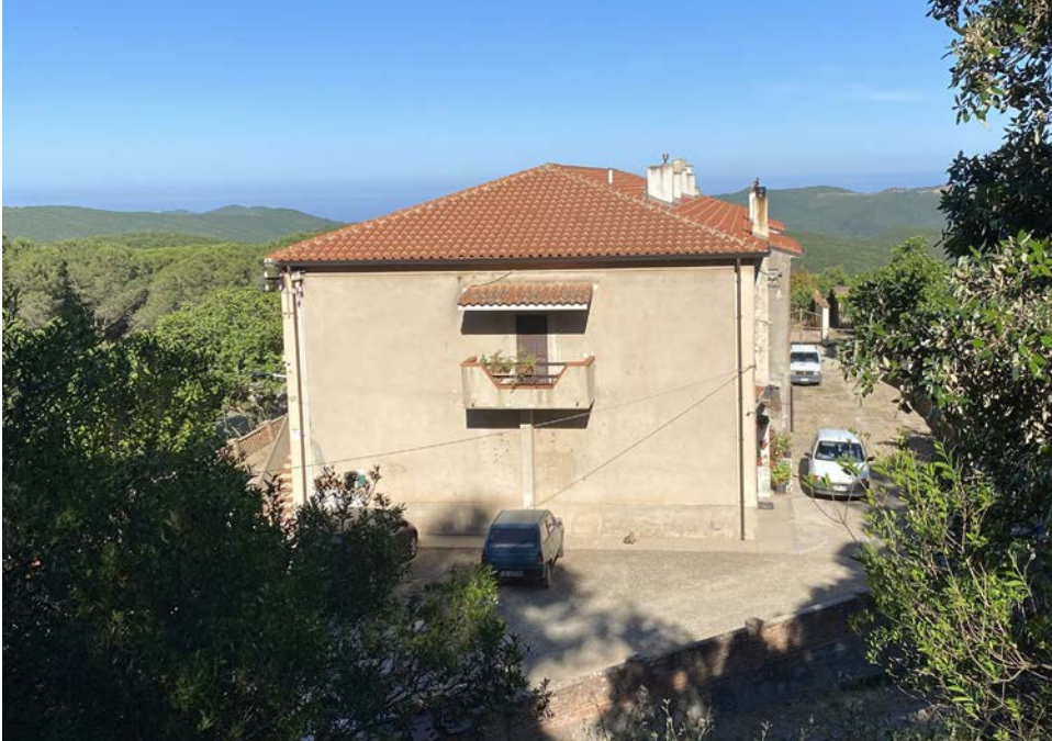
Veduta del prospetto Est
