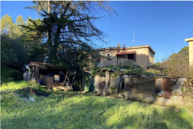
Veduta del prospetto posteriore con recinzioni in lamiera, volume utilizzato come legnaia incongrui e copertura del balcone
