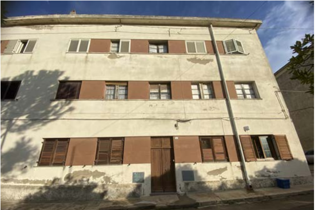
Lato Est del prospetto principale a Sud
