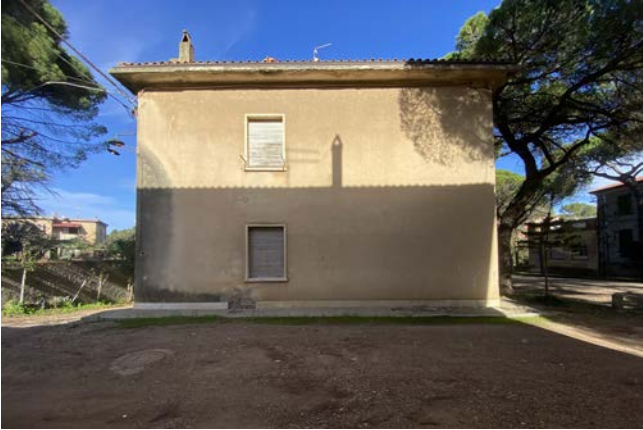
Testata del fabbricato - Prospetto Sud
