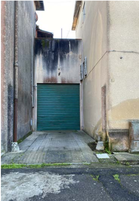
Ingresso carrabile su viale Matteotti
