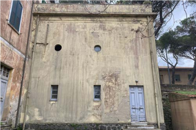
Prospetto posteriore - volume aggiunto
