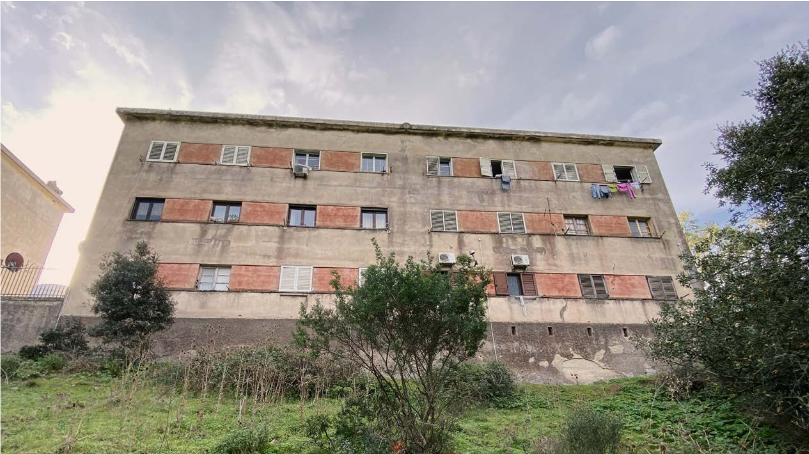
Veduta del prospetto posteriore a Nord
