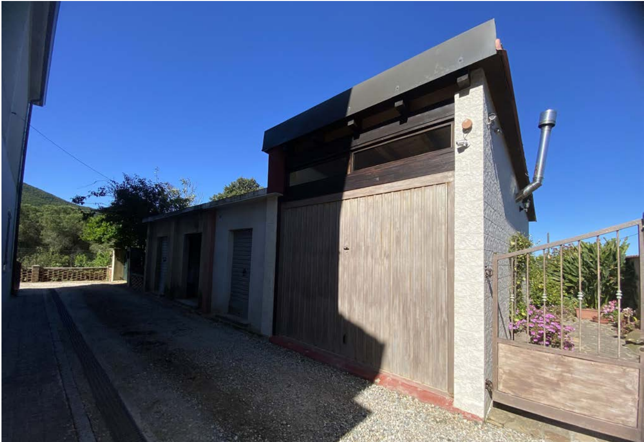
Veduta da Nord-Est
