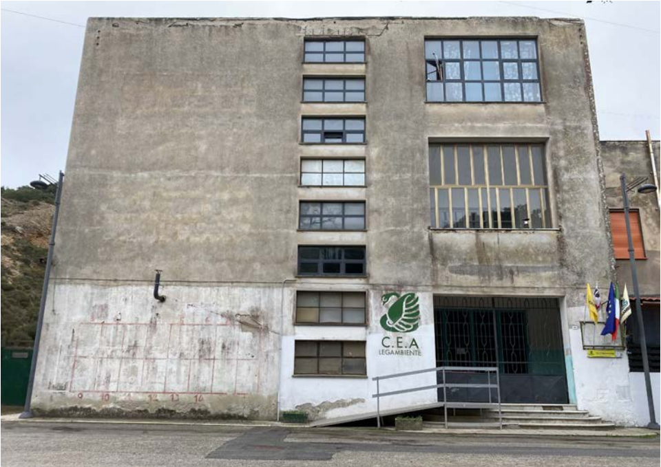
Parte di facciata Nord
