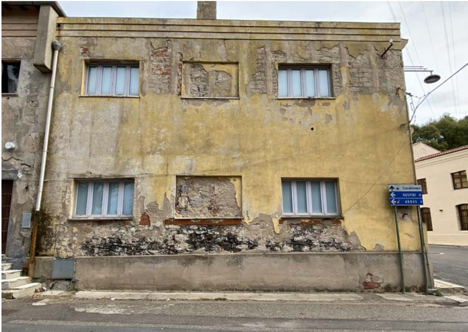
Prospetto Sud-Ovest su viale Vittorio Veneto
