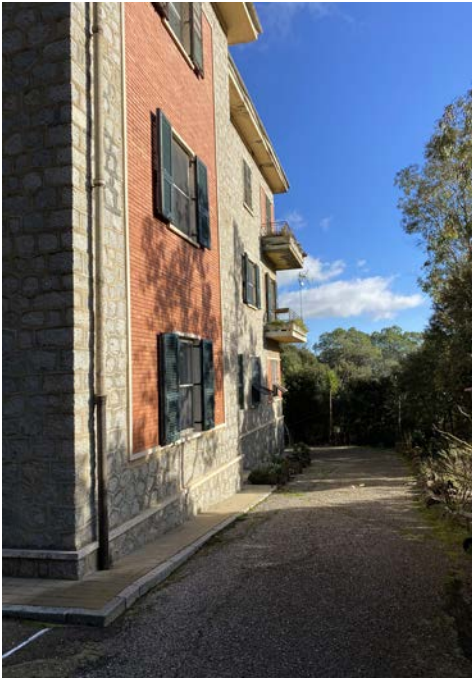
Scorcio del prospetto Sud
