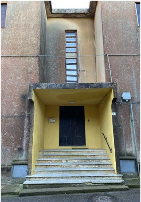
Dettaglio della pensilina di ingresso
