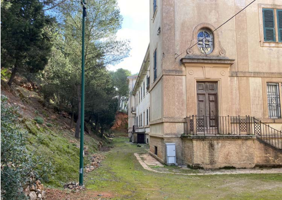
Scorcio sul prospetto Ovest
