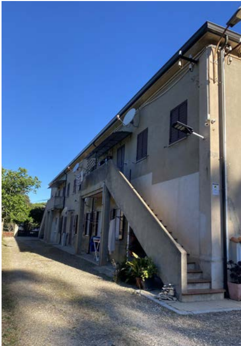
Scorcio prospetto Sud
