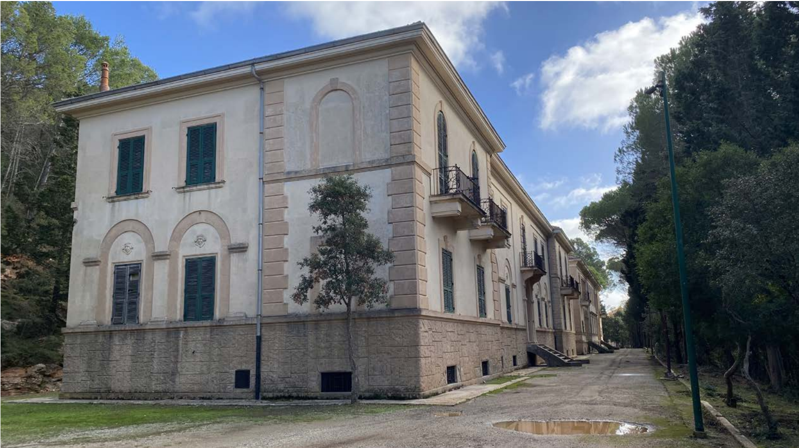
Veduta con in primo piano il prospetto Ovest
