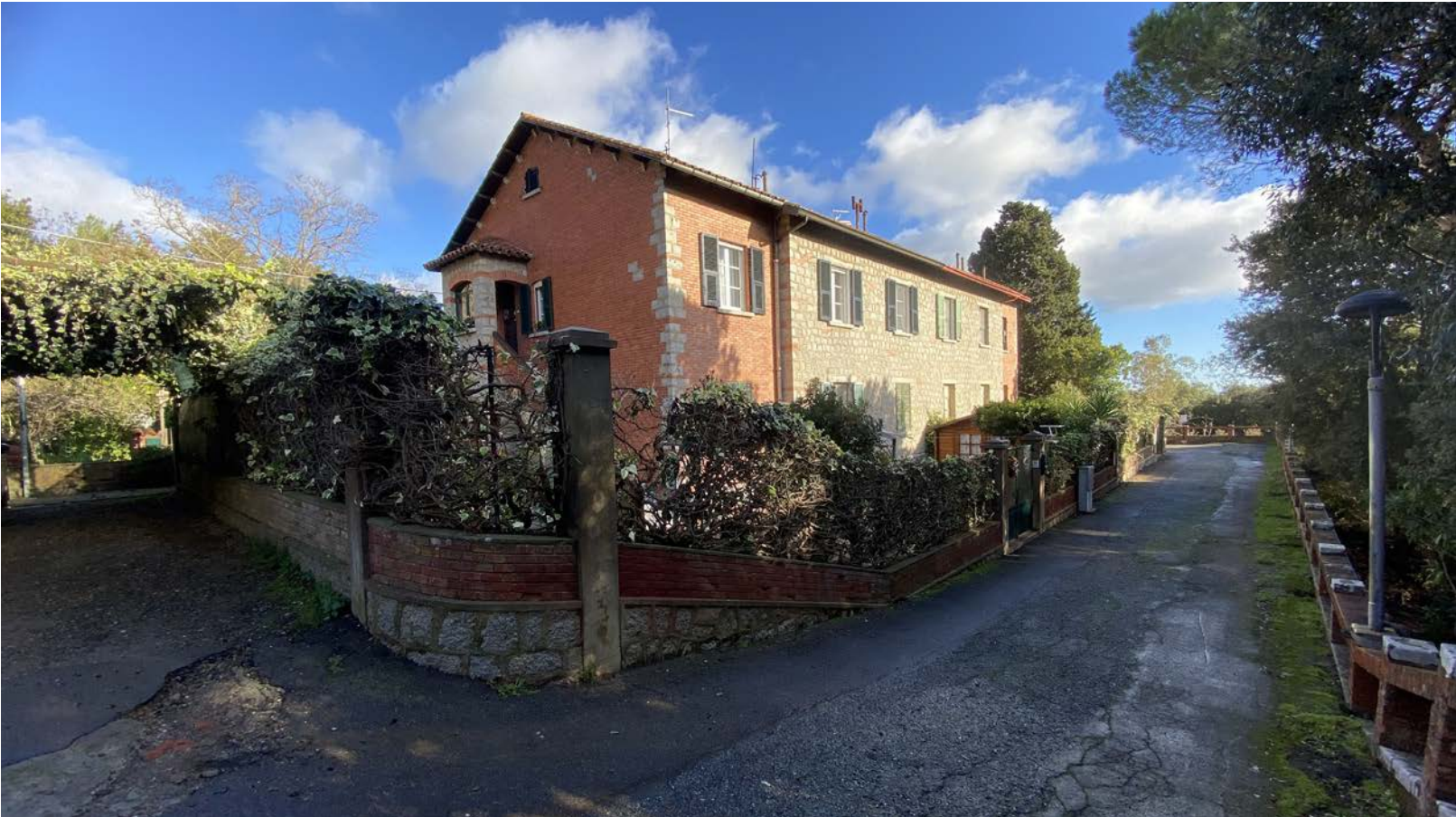
Veduta d'insieme da Sud-Ovest
