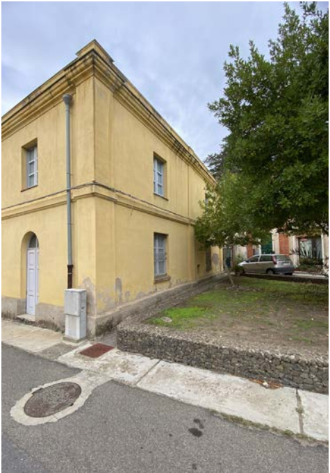
Scorcio del prospetto Nord-Est
