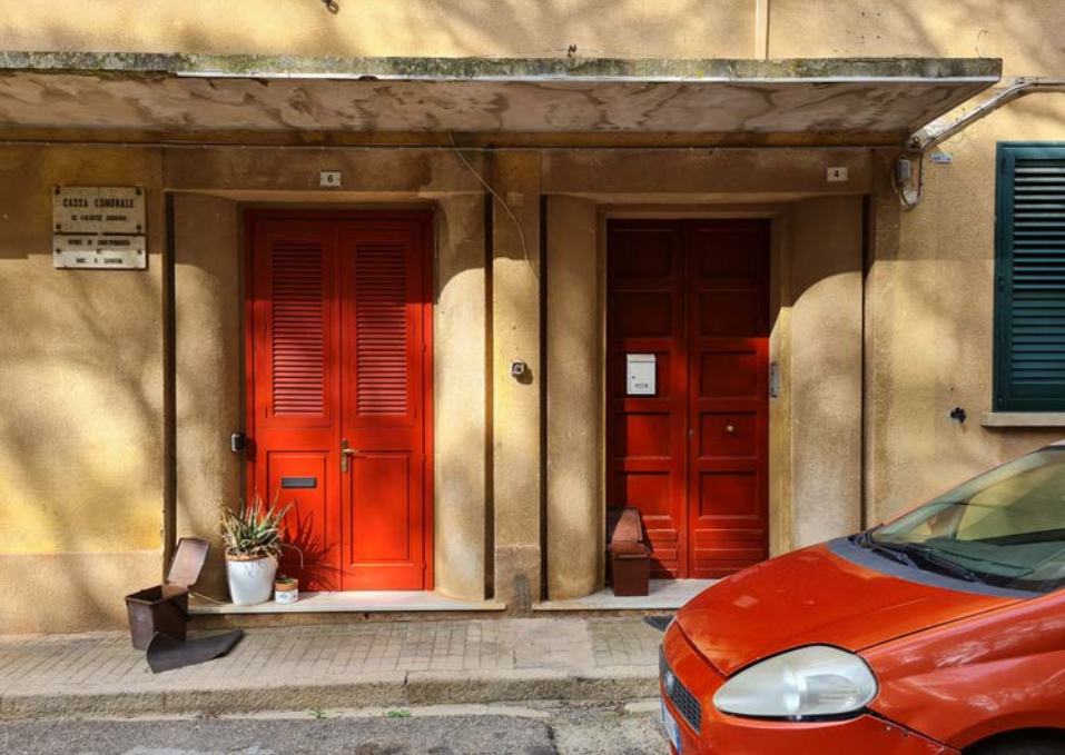
Dettaglio pensilina e portoni d'accesso su via Amendola
