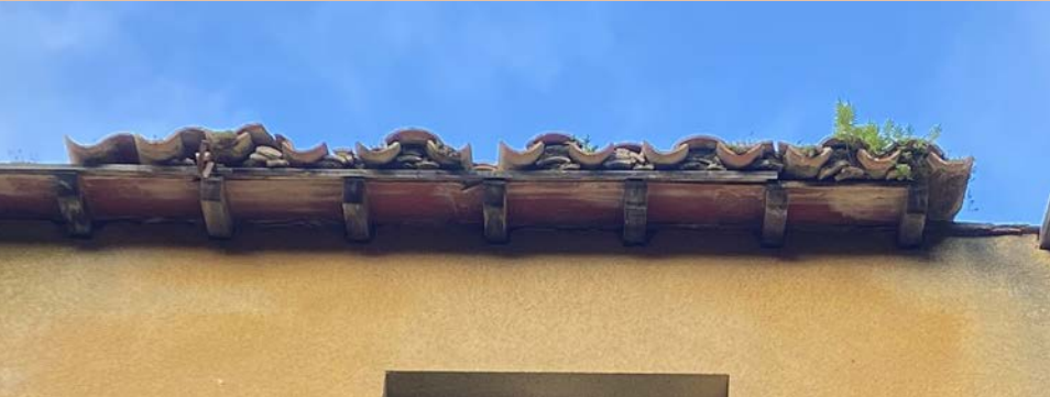
Ripristino in stile del particolare di gronda
