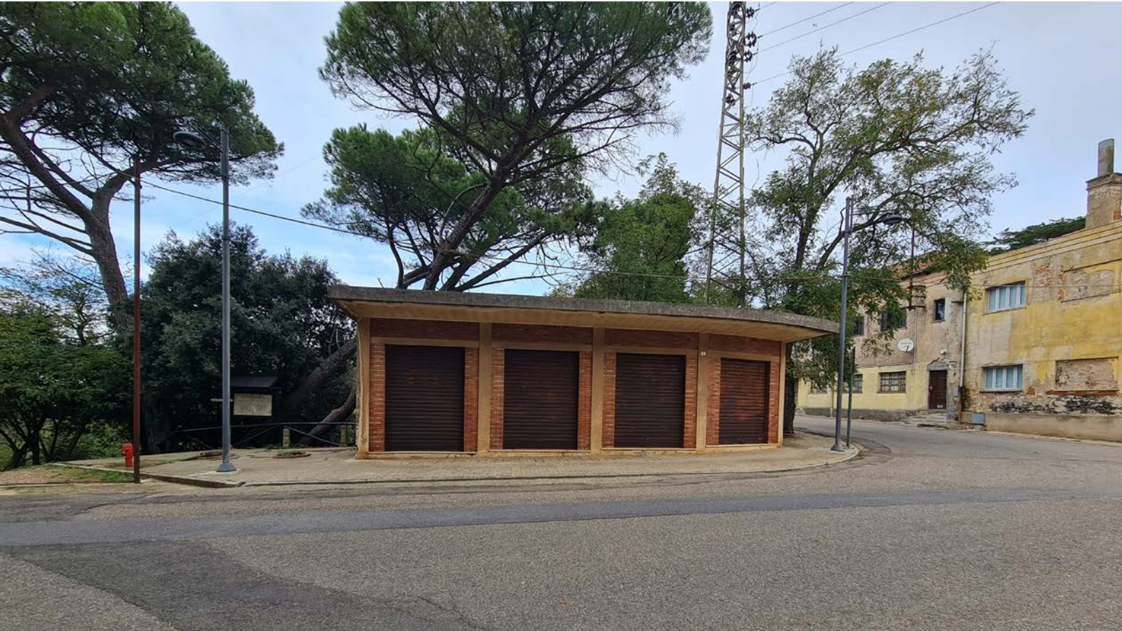
Prospetto principale su via Amendola
