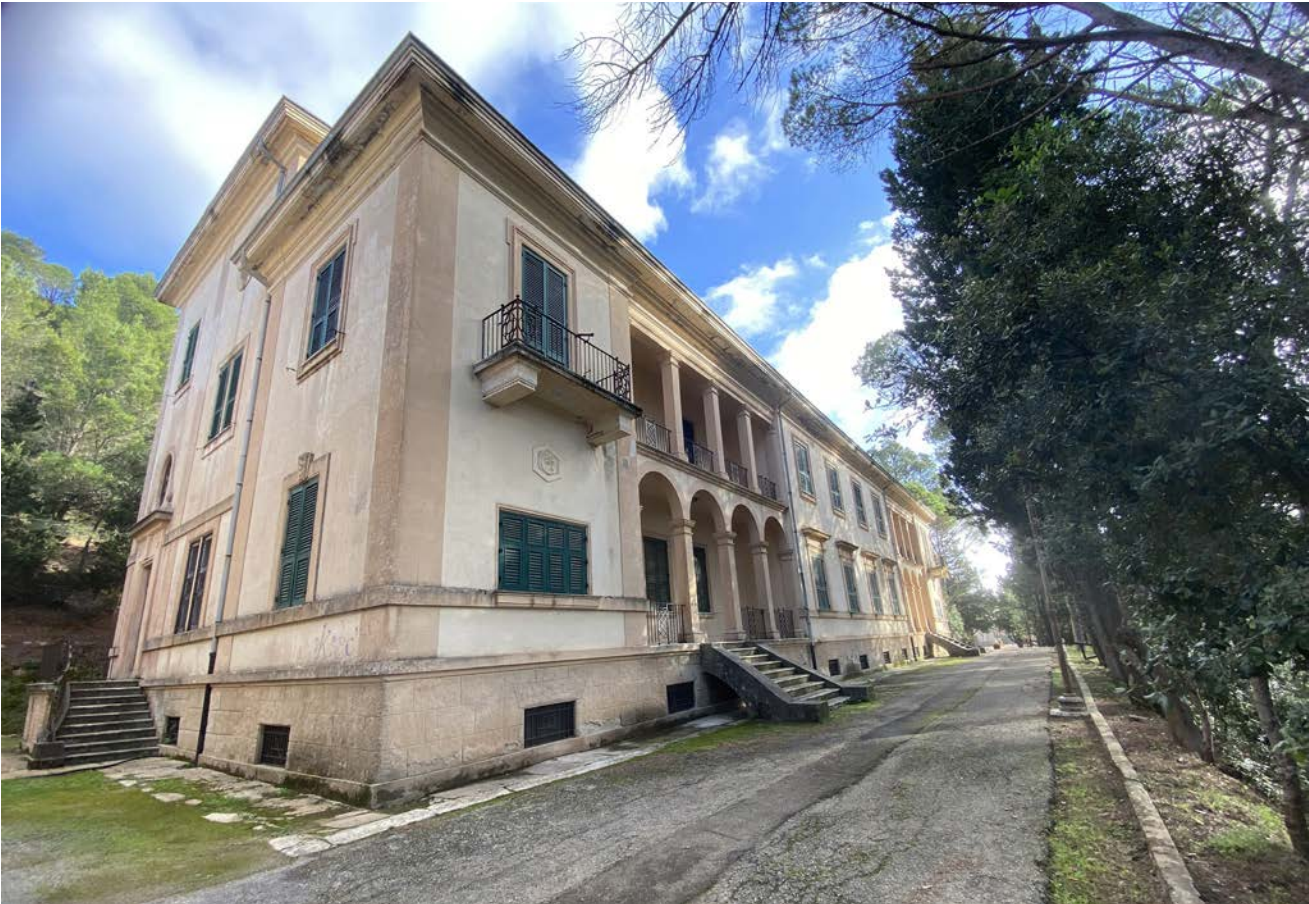
Veduta d'insieme da Sud-Ovest
