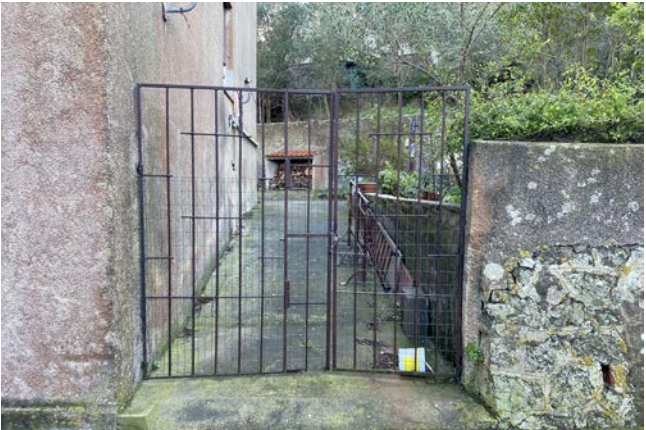
Ingresso carrabile sul prospetto Sud-Ovest
