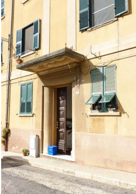
Dettaglio pensilina di ingresso
