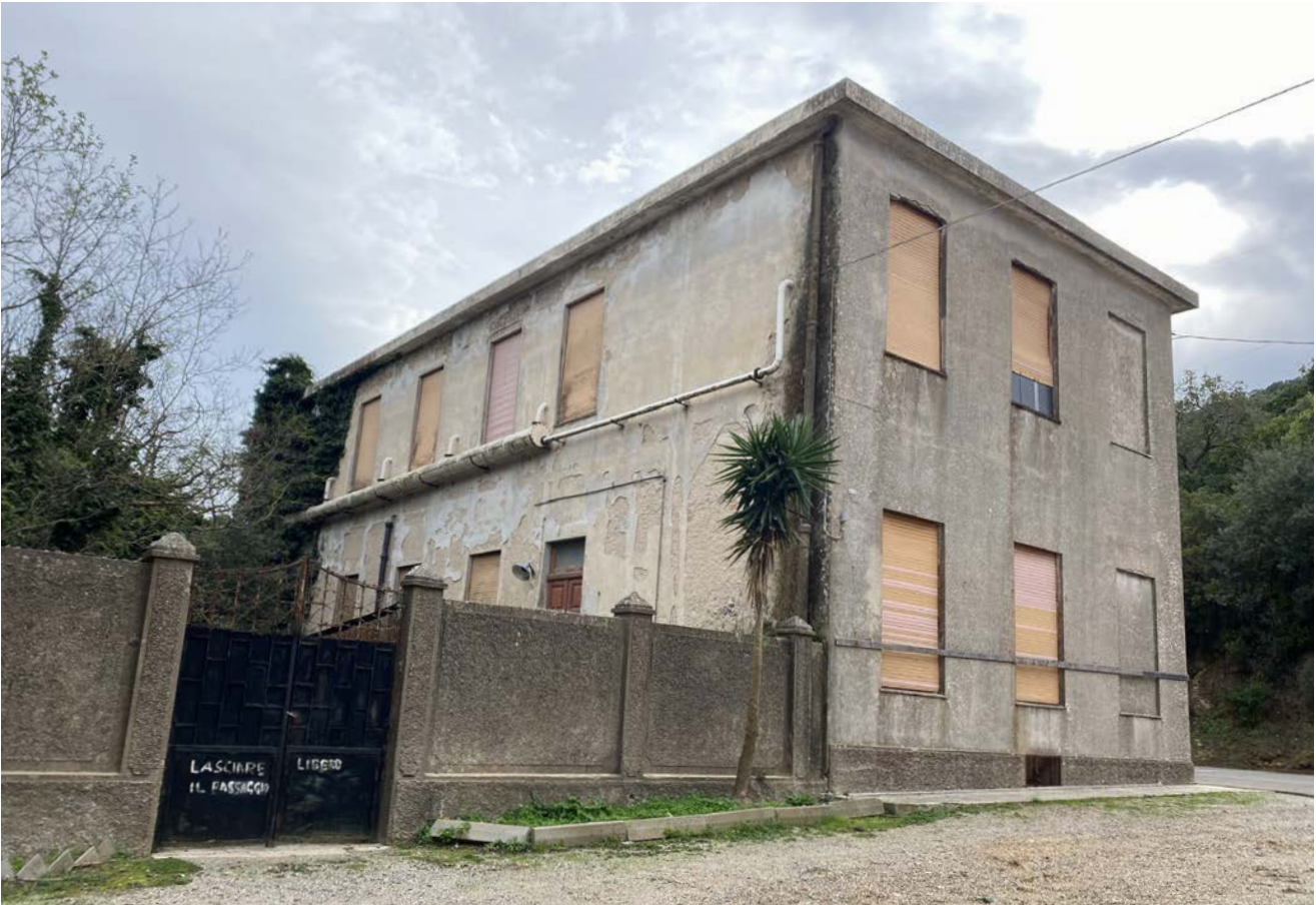
Veduta e prospetto Ovest e cortile
