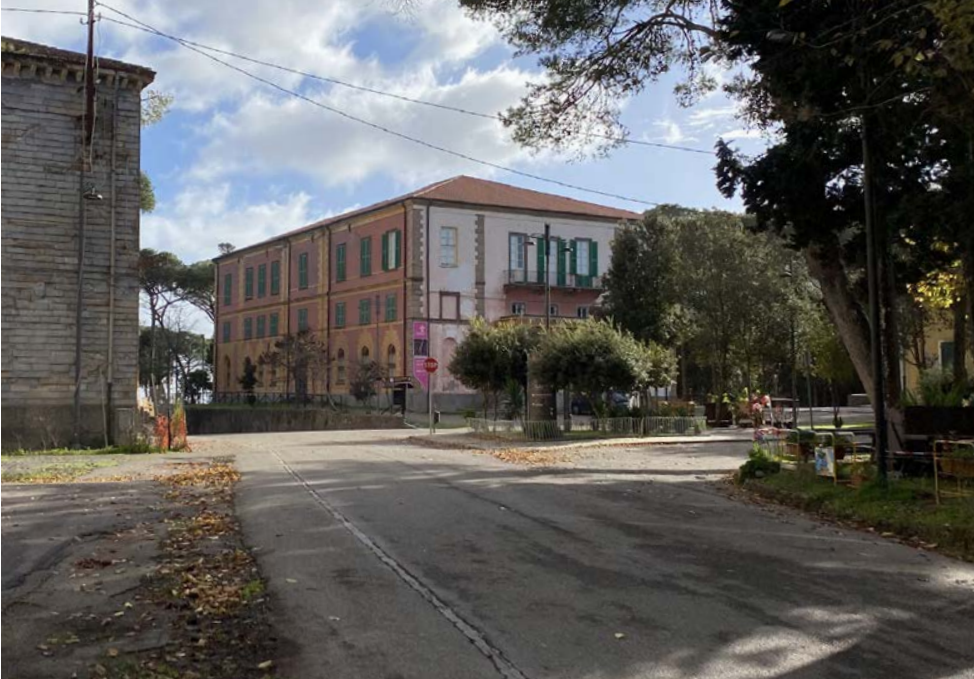
Veduta d'insieme da Nord-Ovest
