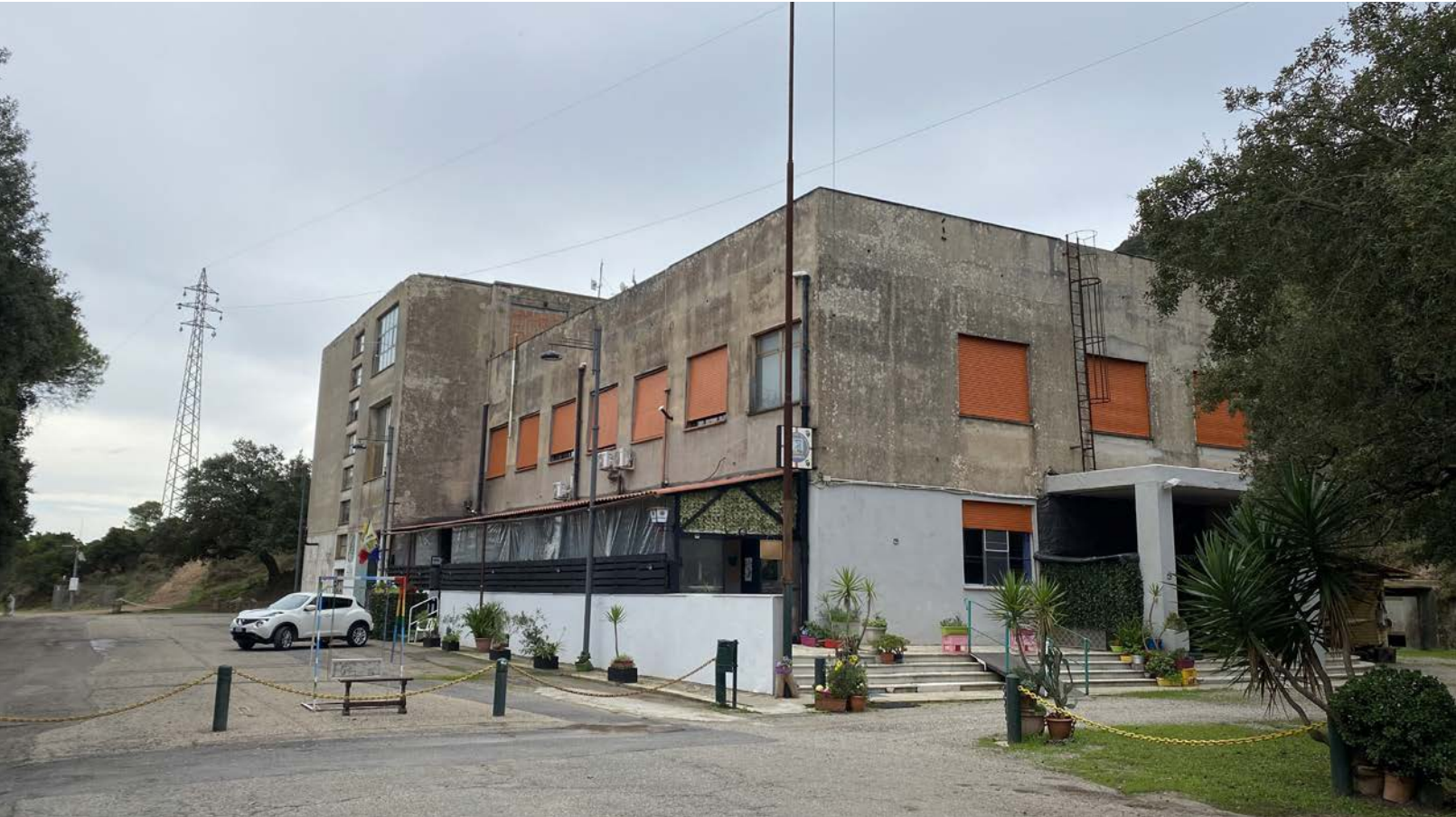
Veduta d'insieme da Nord-Ovest con veranda incongrua
