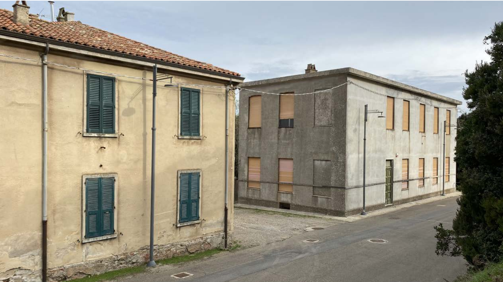
Veduta d'insieme da Sud-Ovest
