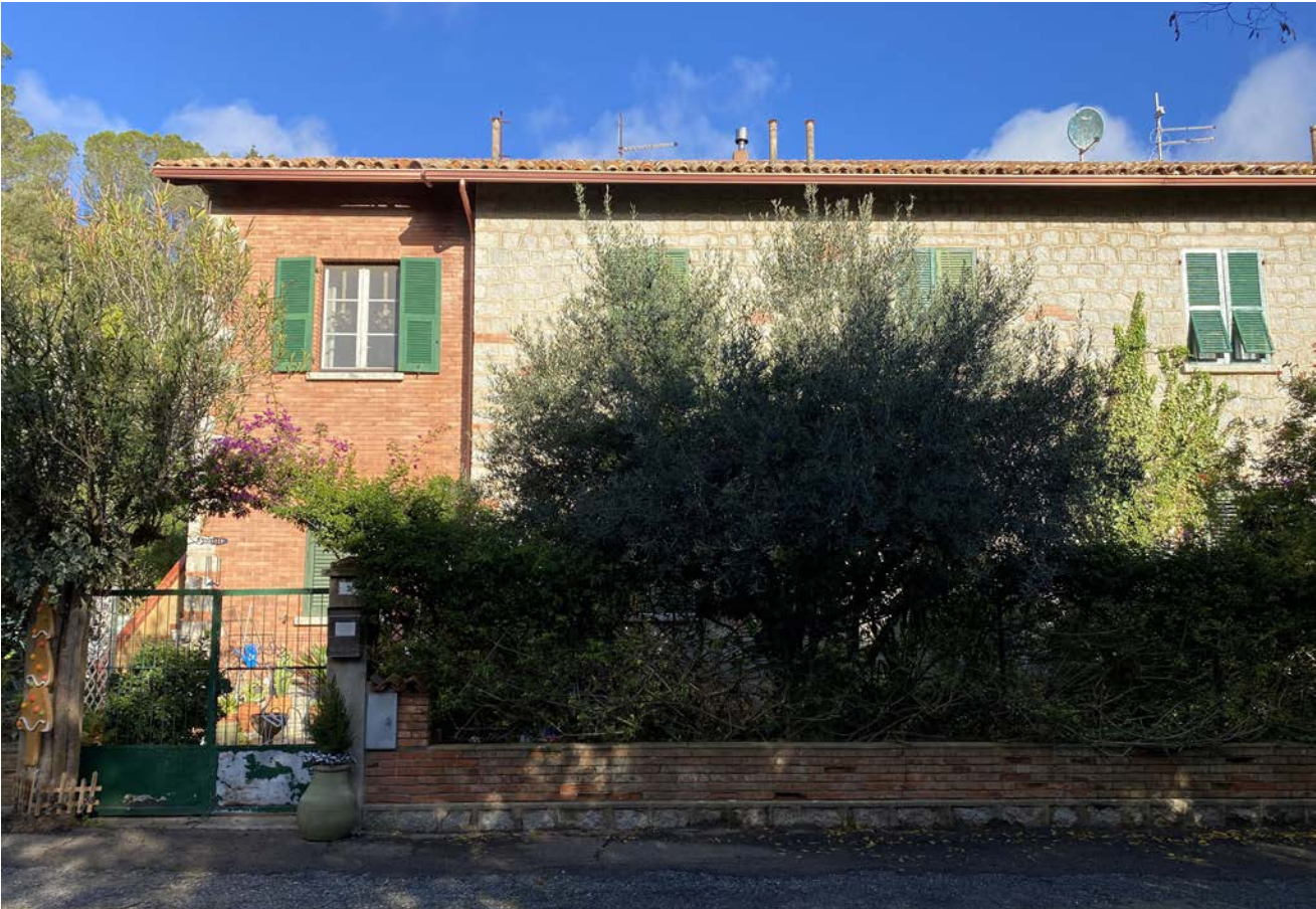
Scorcio del prospetto Sud
