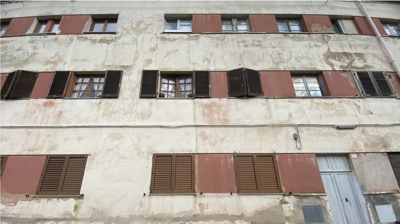
Dettaglio facciata principale su via del Mare
