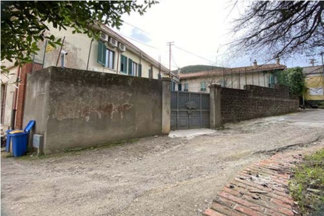
Veduta della recinzione del cortile
