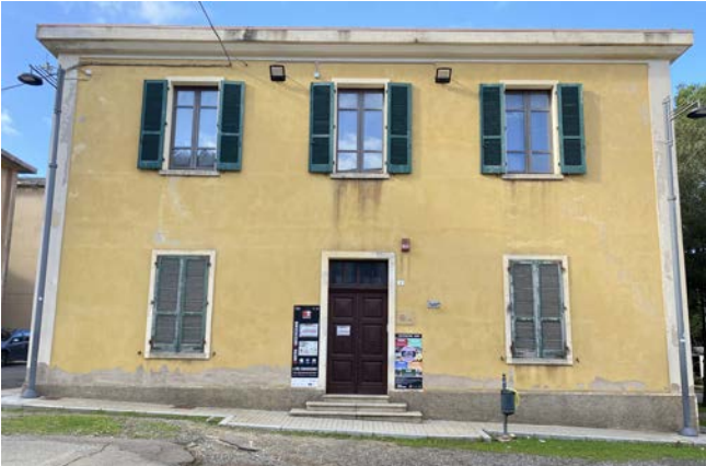
Prospetto principale (Est) su Piazzale Rolandi
