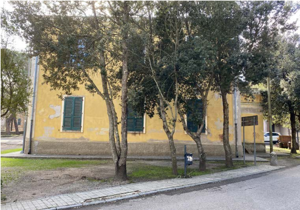
Veduta del prospetto Nord
