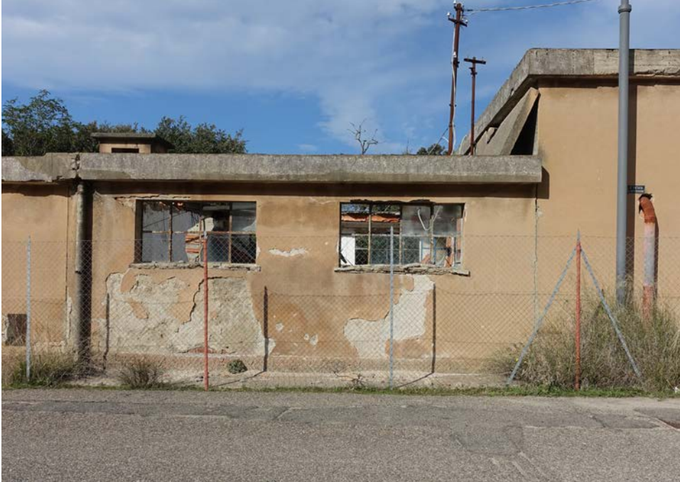
Scorcio del prospetto su viale Amendola
