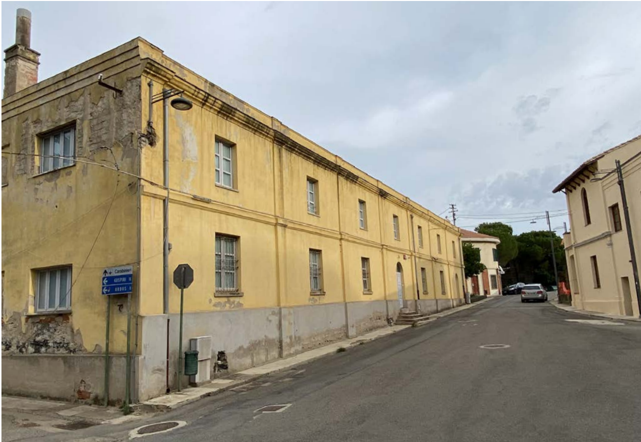
Veduta da Sud del fronte principale
