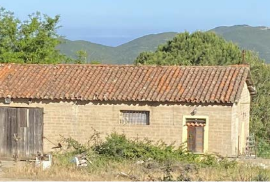
1 Tetto a due falde su solaio ligno con manto di copertura in tegole tipo coppo
