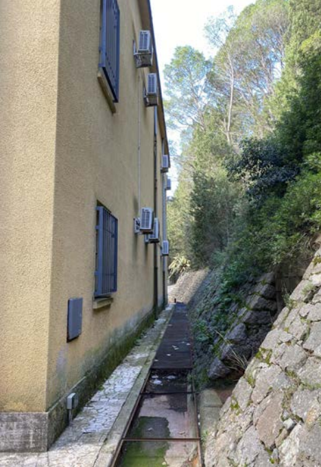
Retro del fabbricato
