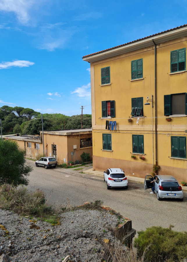
Veduta d'insieme su via Amendola
