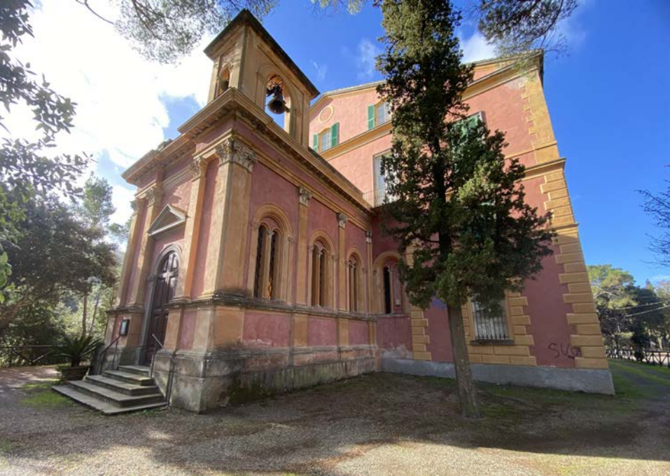
Il volume della cappella di Santa Barbara sul fronte Est
