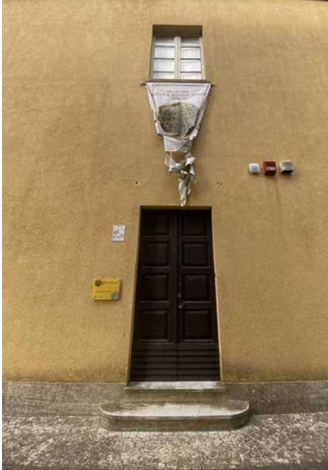
Portone di accesso su prospetto Est
