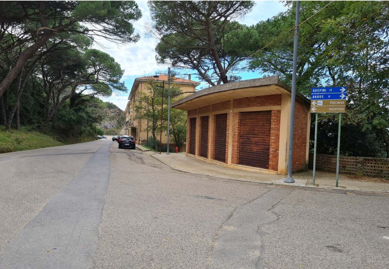
Veduta d'insieme dall'incrocio tra viale Matteotti e viale Amendola
