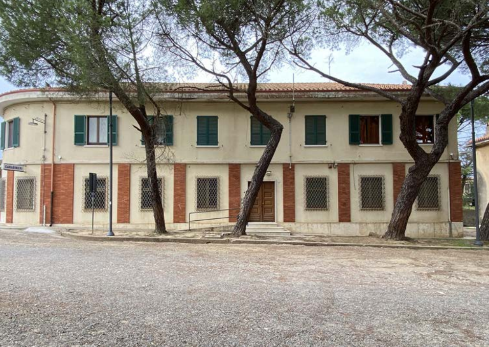
Facciata Est su viale Gramsci
