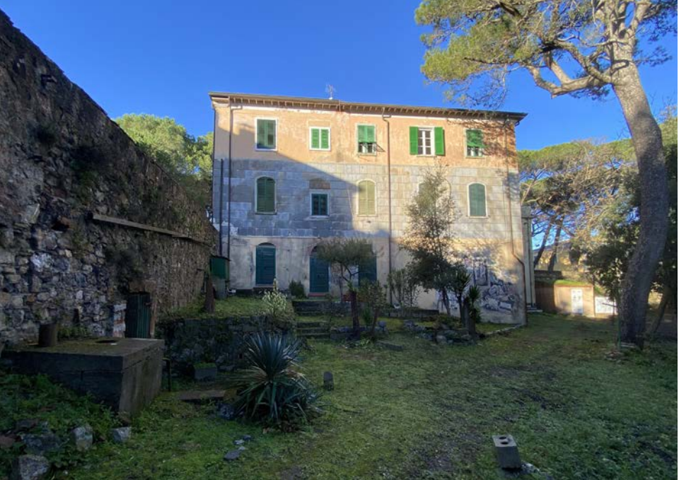
Veduta della facciata Est con alterazioni incongrue dell'impaginato
