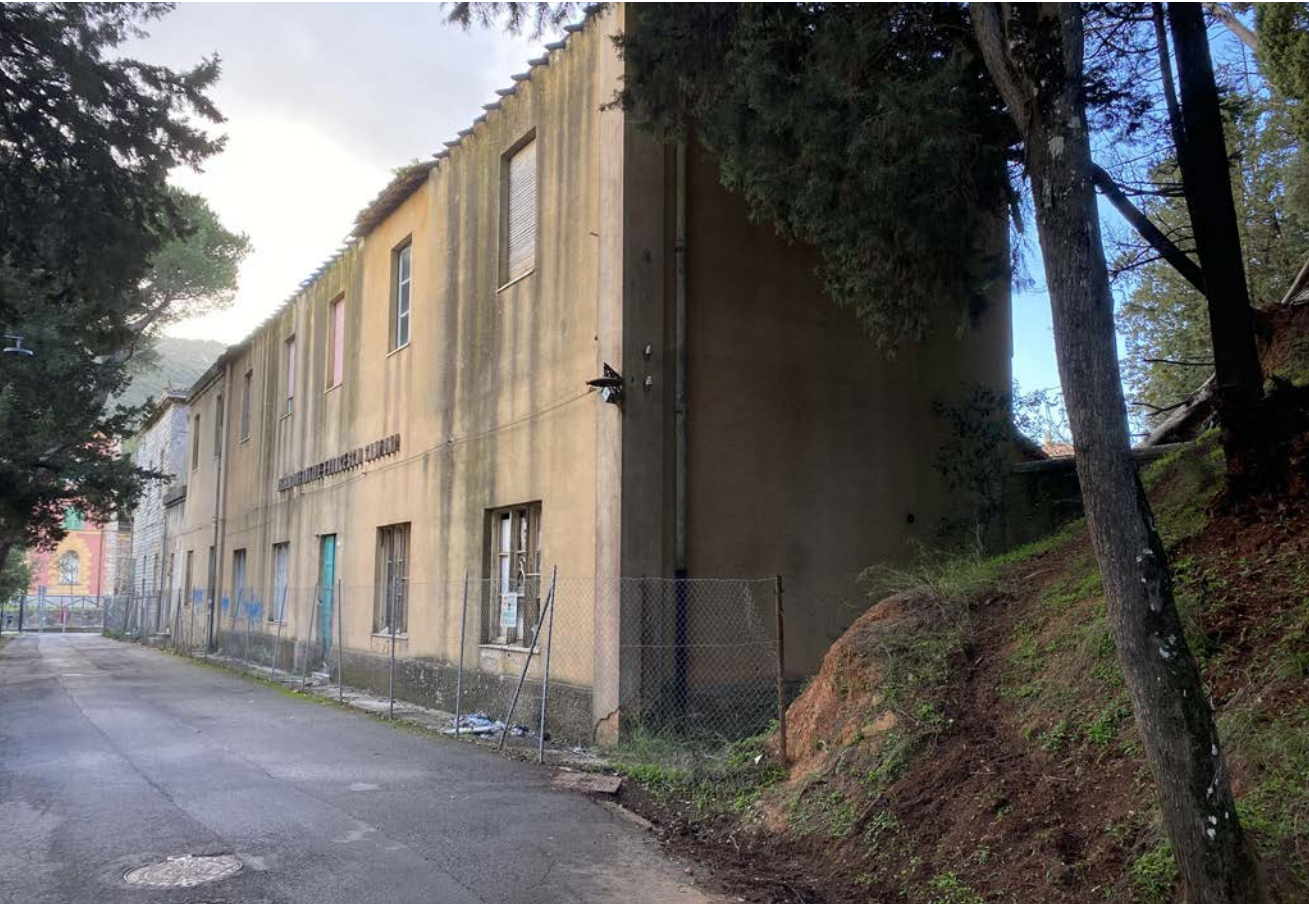
Scorcio del fronte su viale dei Pini da Nord
