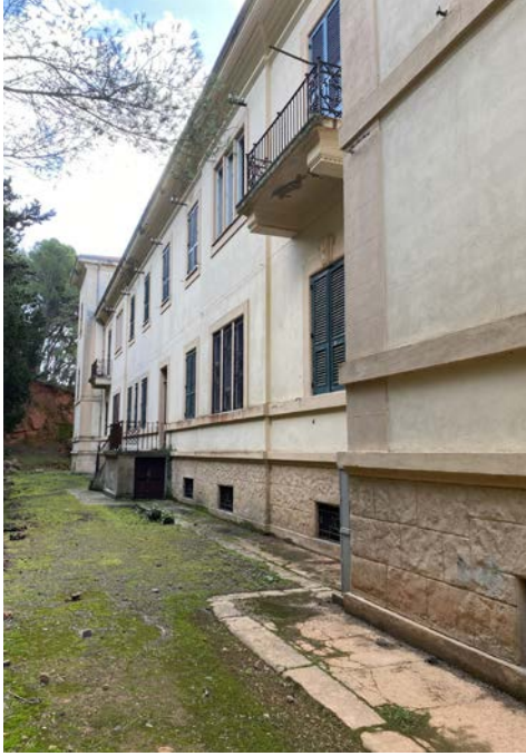
Prospetto retrostante a Nord
