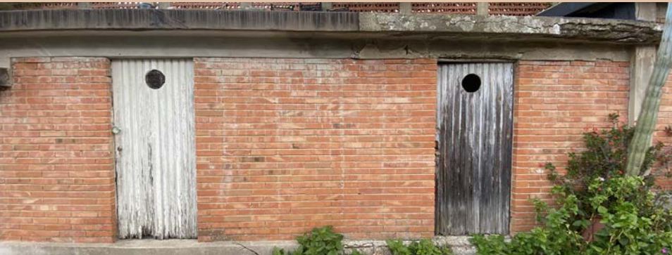
Elemento da preservare, per colorazioni e per rapporto pieni/vuoti.
