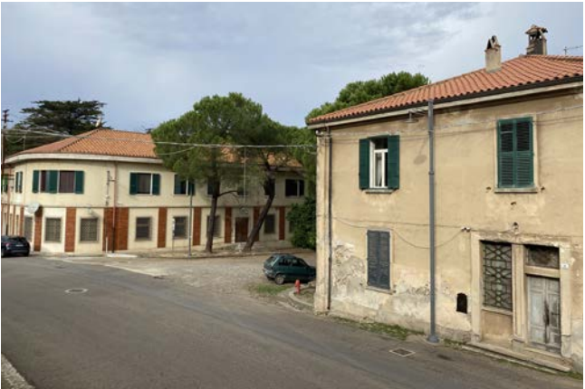
Veduta d'insieme da Sud-Est
