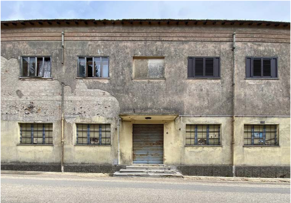
Parte del prospetto principale su viale Vittorio Veneto
