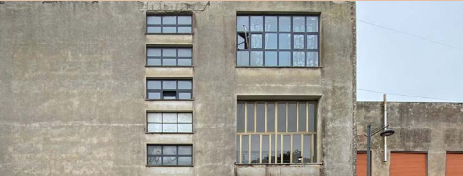
Aperture da preservare con le logge da aprire o i serramenti da omogeneizzare
