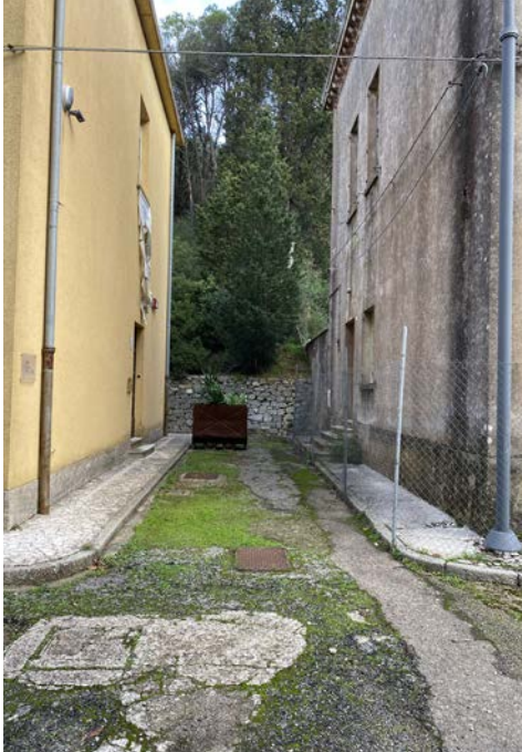
Spazio di passaggio tra edificio 4 e 5
