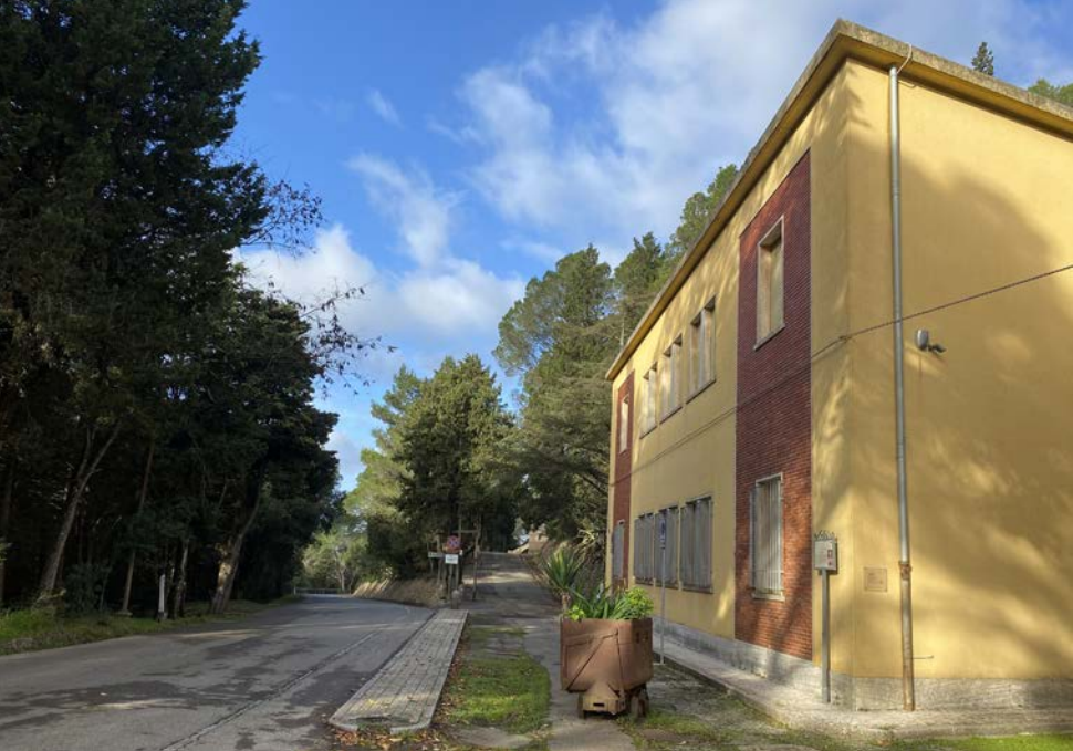
Scorcio del prospetto principale da Est
