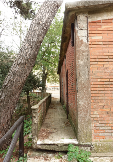
Dettaglio percorso pedonale sul retro
