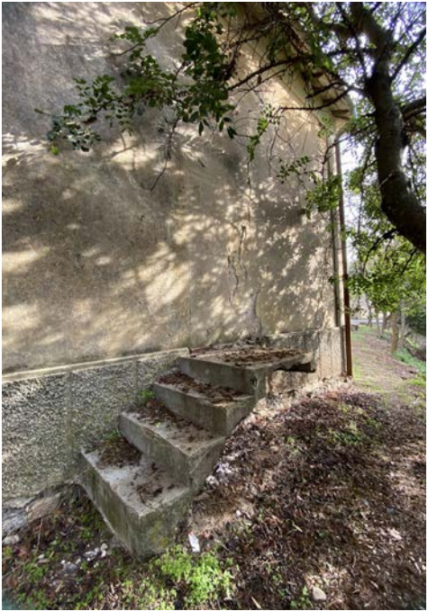
Dettaglio scala su prospetto posteriore
