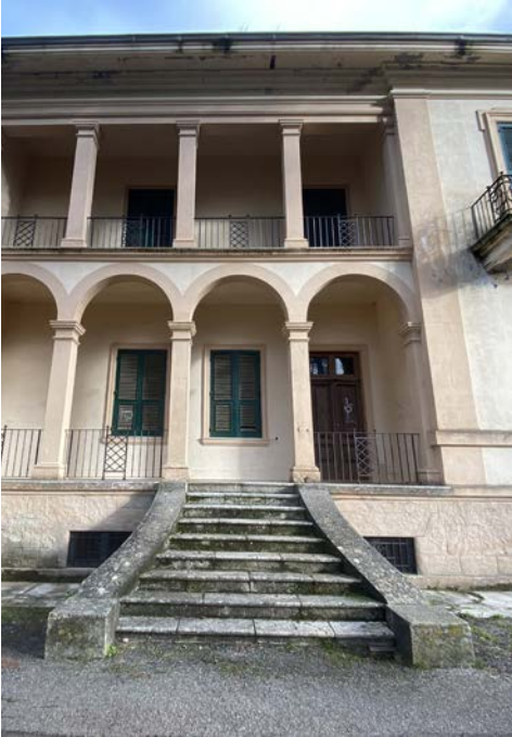
Dettaglio delle logge sul lato Est
