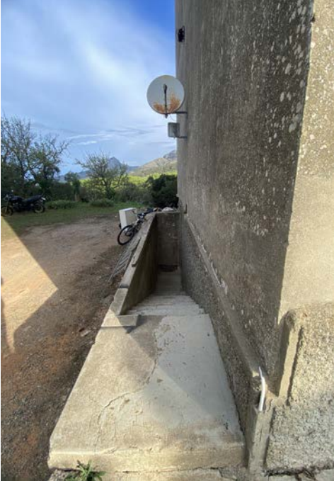
Dettaglio scala di accesso alle cantine
