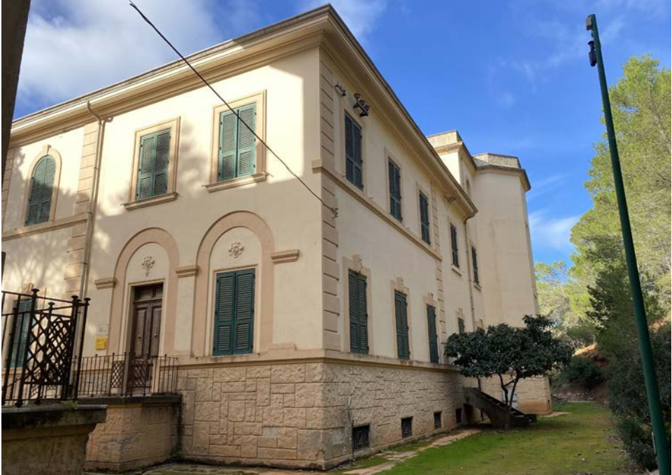
Veduta sul retro da Est
