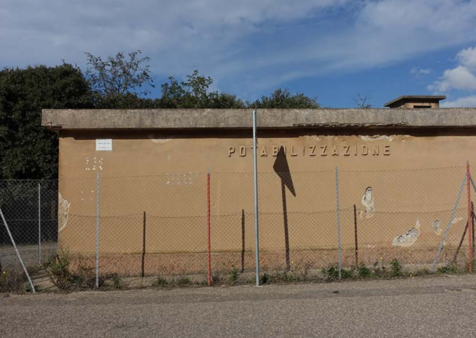
Scorcio del prospetto su viale Amendola
