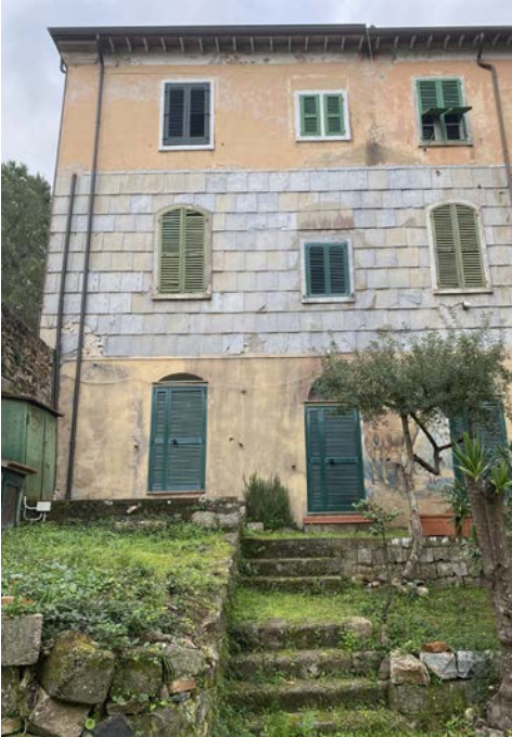
Dettaglio di facciata Est
