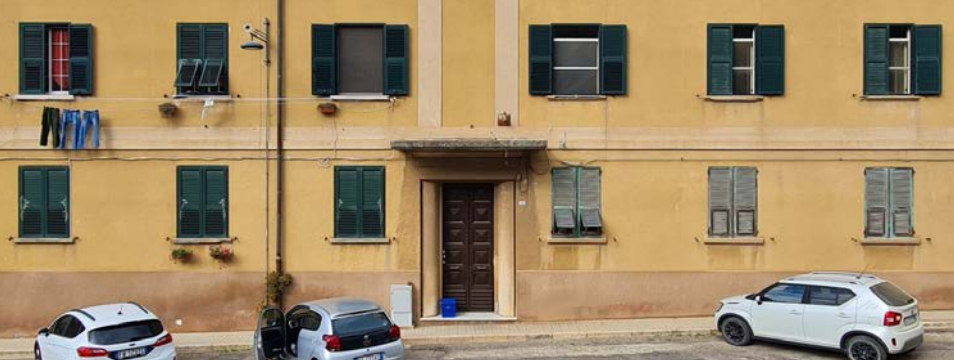
Pensilina di accesso con portone bugnato e stipiti sagomati, e fasce di ripartizione
