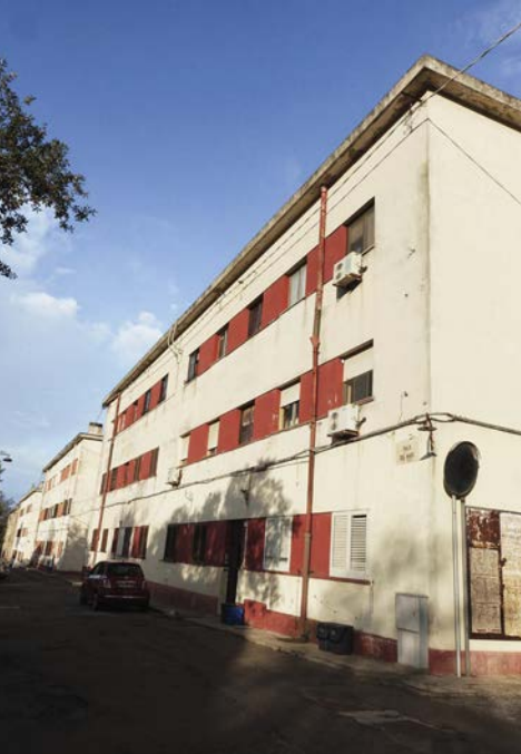
Veduta del prospetto principale
