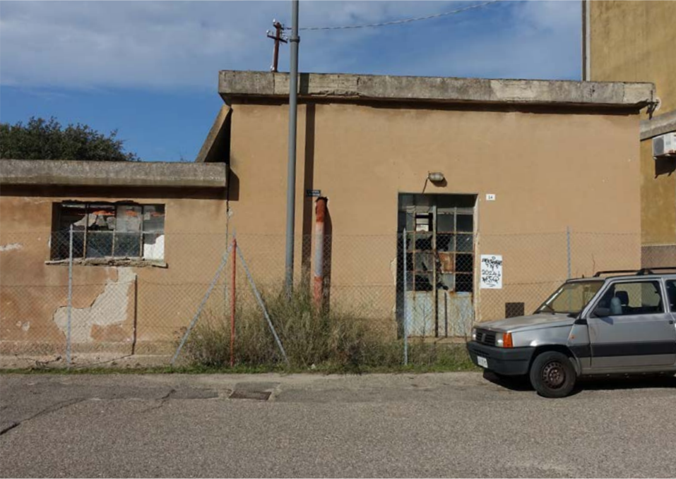
Scorcio del prospetto su viale Amendola
