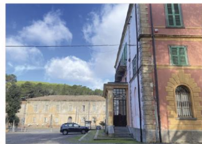
Scorcio della facciata a Ovest
