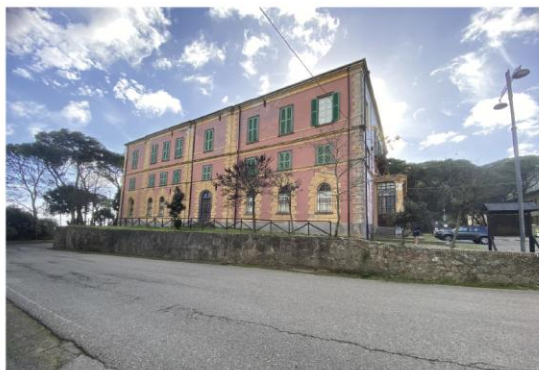
Prospetto Nord dalla strada provinciale n. 65
