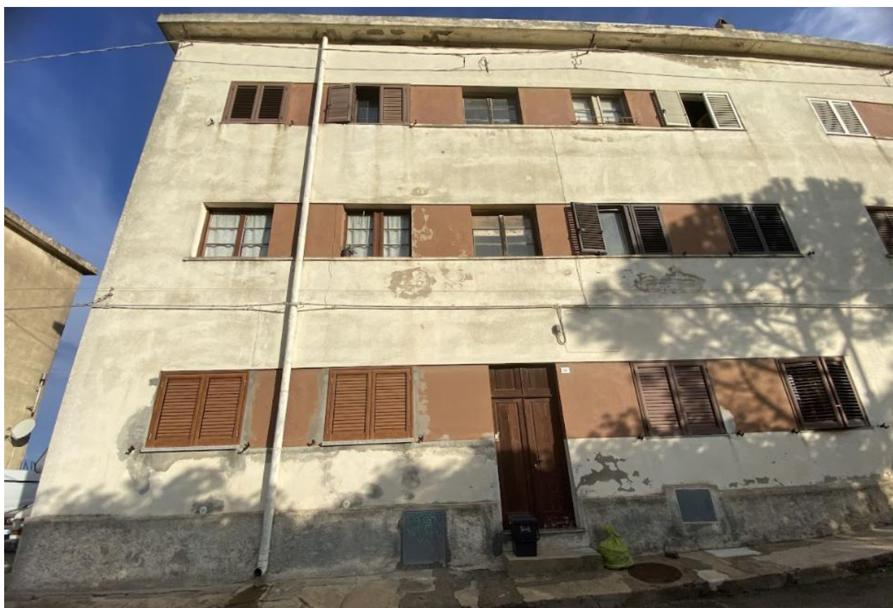
>> Palazzina in via del Mare
