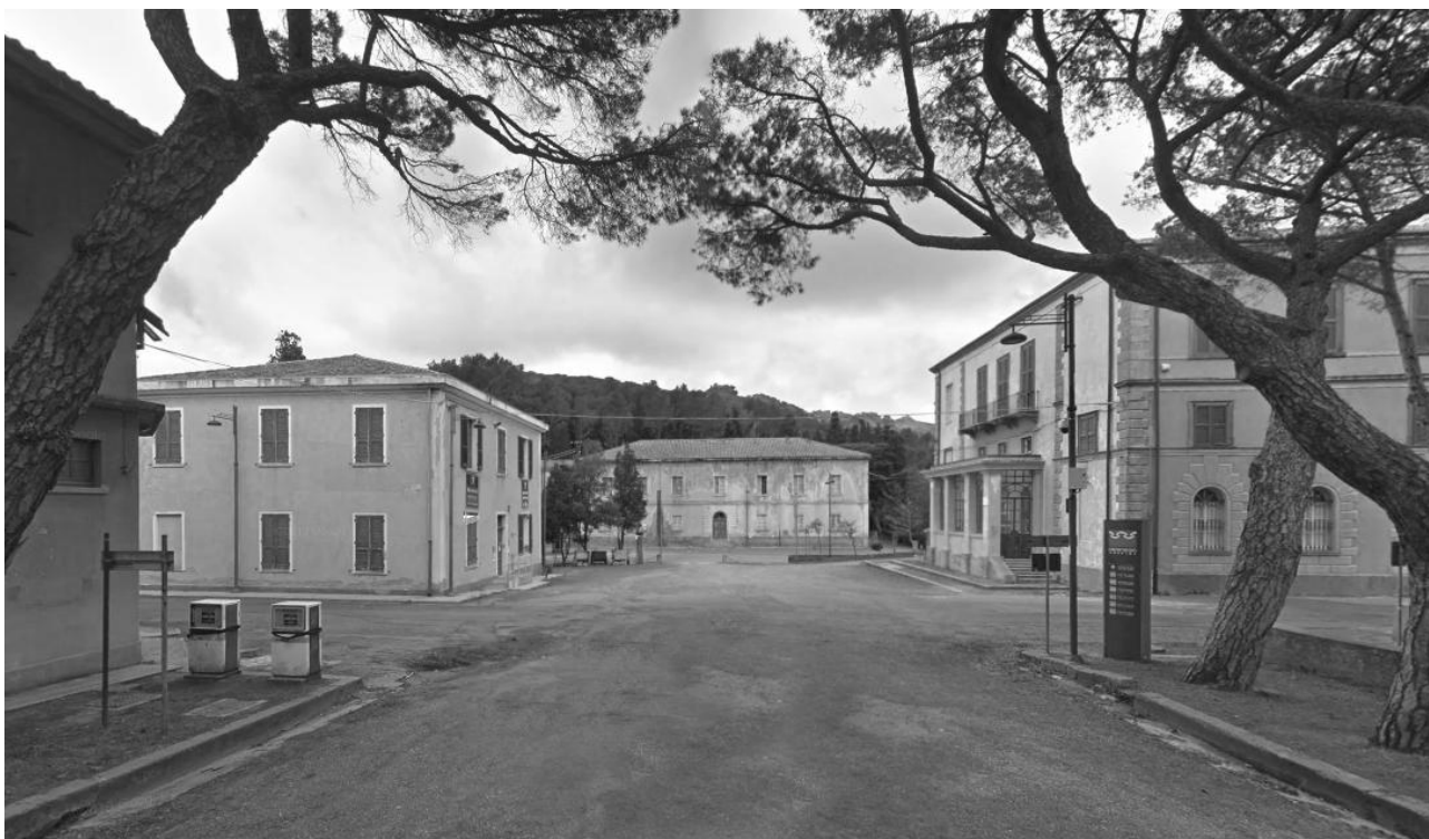
>> Vista dell'edificio dell'Ospedale: controcampo dell'asse prospettico del piazzale Rolandi, in origine Viale Impero
