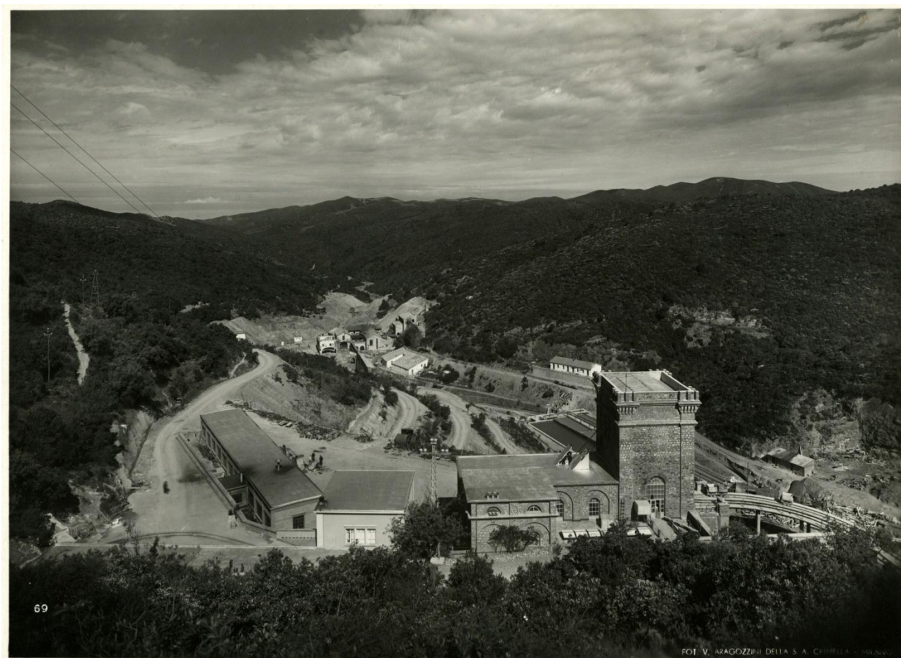
>> immagine storica del Cantiere Piccalinna – Montevecchio Levante (tratta da www.movio.beniculturali.it )
