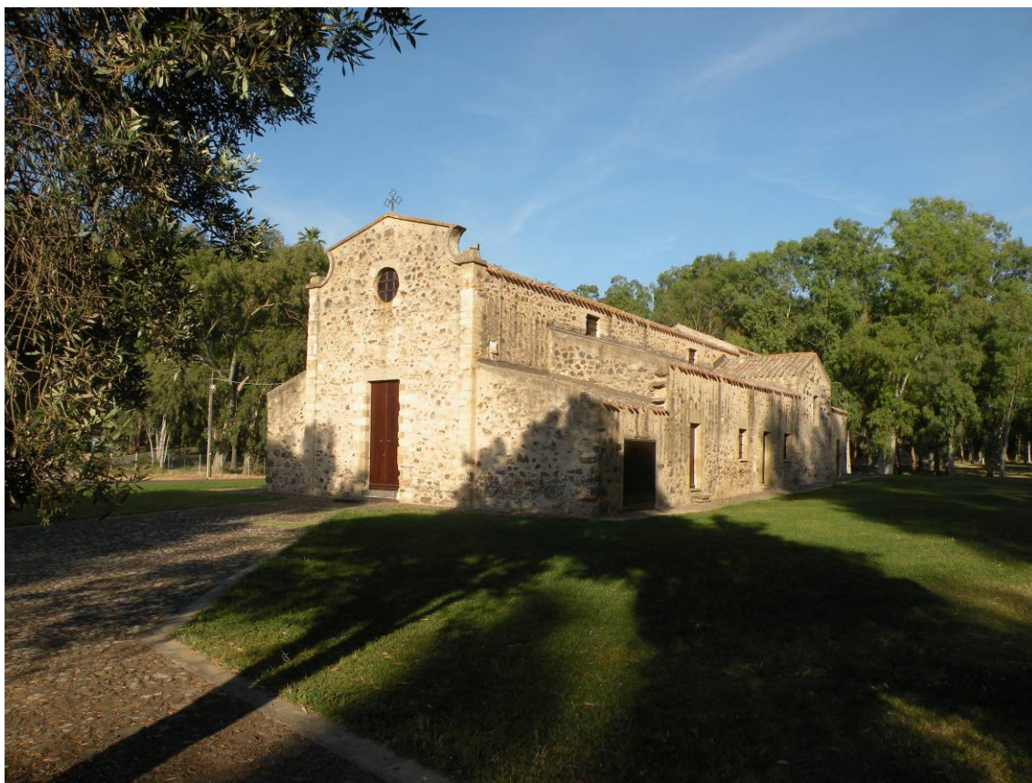
Figura 7 - Chiesa di Santa Maria Is Acquis di Sardara.
