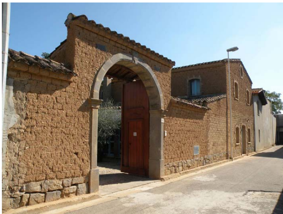
Figura 8 - Esempio di architettura tradizionale realizzata in terra cruda, "Sa domu e Nannai" a Samassi.
