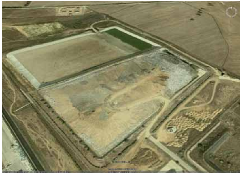
Figura VII-1 Vista dei due moduli della discarica di Villacidro
